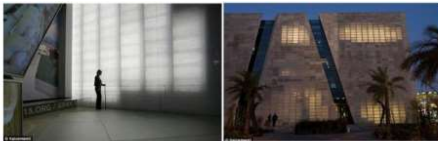
بالصين الذى استخدم فى تصميم واجهته EXPO 2010 (صورة 5 أ ، ب ) توضح الجناح العالمى بشنغهاى الخرسانة الشفافة ، والتي استخدمت لإعطاء البساطة للمبنى فى التشكيل والتصميم فهي تتميز بخفة وزنها وأنها مادة غير ضارة وصديقة للبيئة ويمكن إعادة تصنيعها ، كما أنها ذات شفافية وروية عالية . http://egy-arch.blogspot.com.eg/2011/04/transparent-concrete.html
