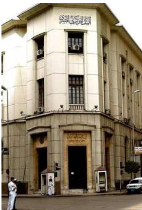
الشكل (13) البنك المركزي المصري **يوضح معرفة اسم المبنى من الكتابة الموضحة عليه.
